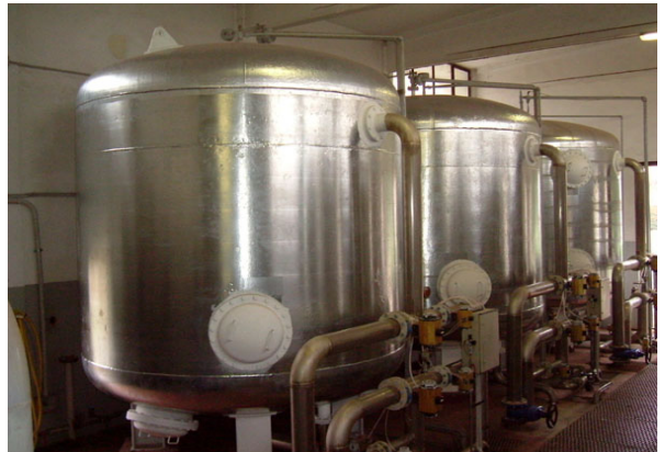
Tanques Después de ser Protegidos Mediante Galvanode® Cinta de Zinc
