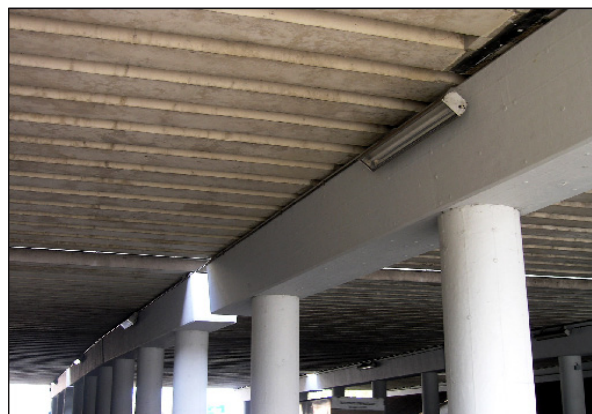
Aplicación en la Subestructura de un Puente
