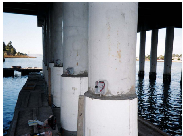
Galvanode SAD Marino dentro de formaleta definitiva FRP
