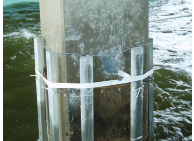
Sistema Galvanode SAD Marino en pilote, antes del encapsulamiento en chaqueta de concreto
