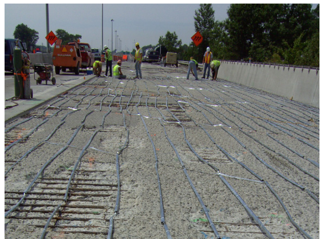
Sistema Galvánico de ánodos en losa de puente antes de colocación de nueva carpeta de concreto
