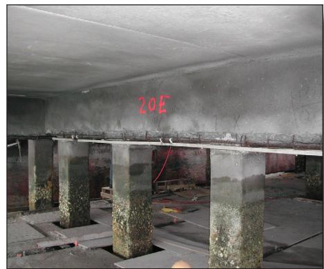
Galvanode DAS on Pile Caps
